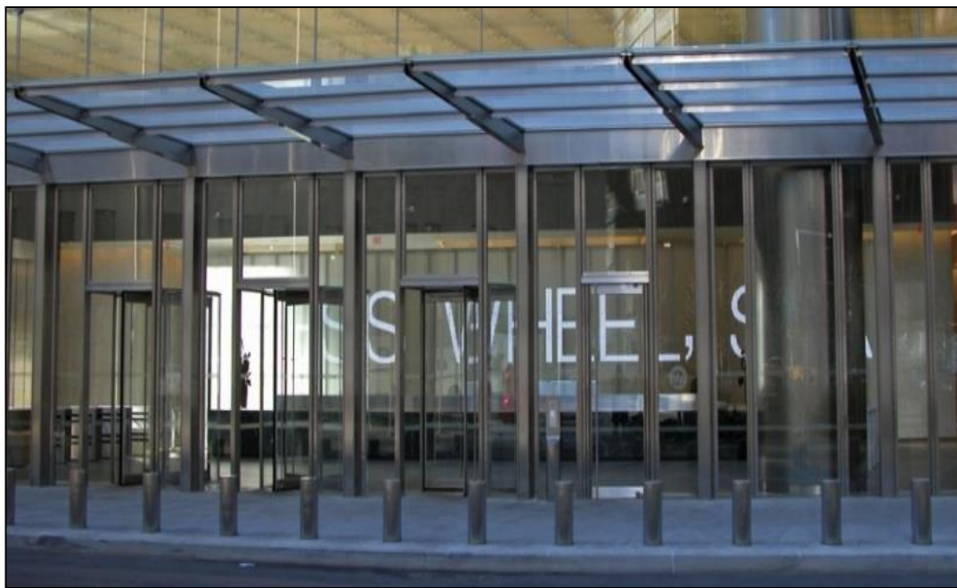
Colunas resistentes a explosões na entrada do Seven World Trade Center, Nova York
