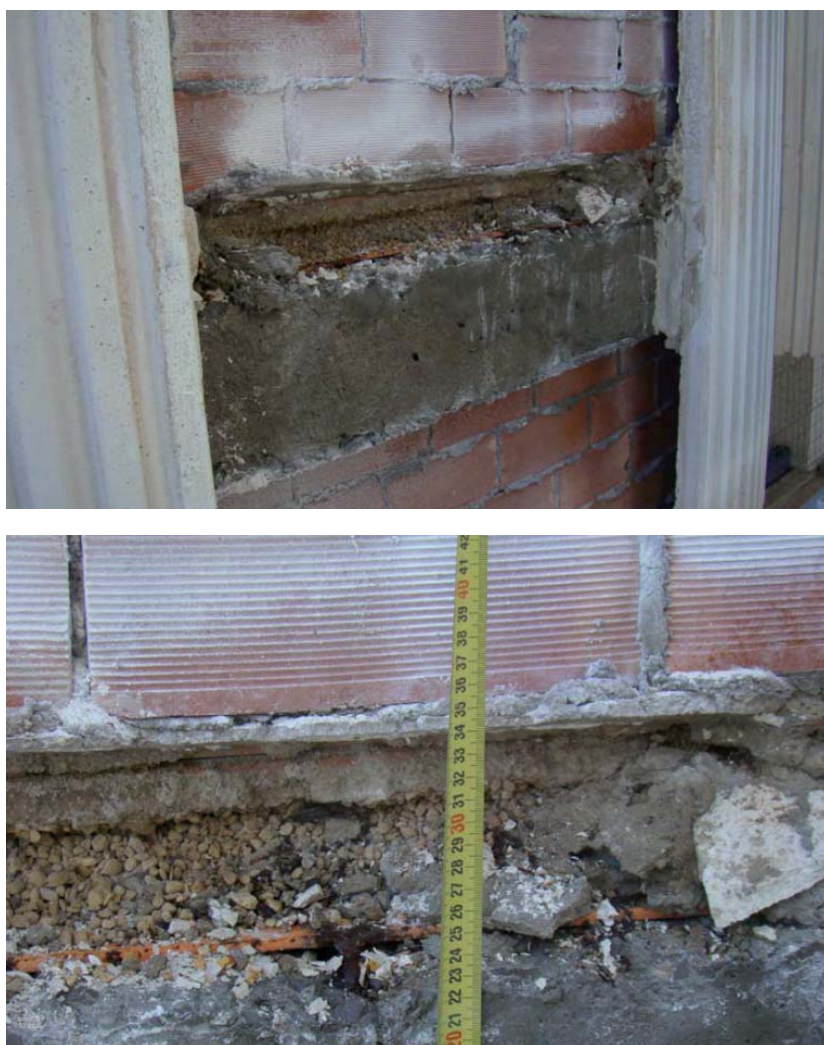
Figura 14 Detalle de las piezas de acero ancladas a borde de forjado.
