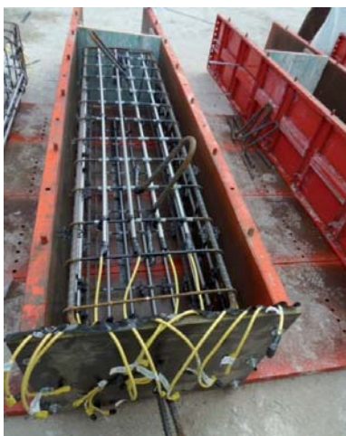
Figura 8 Colocación de la estructura en el molde.
