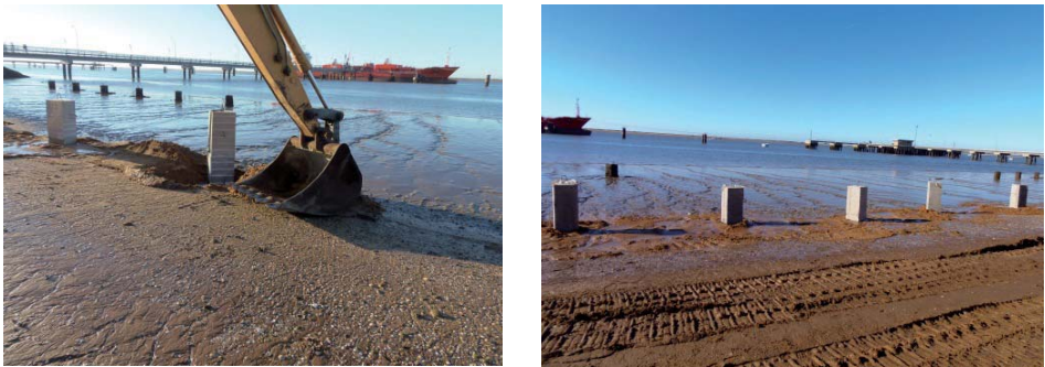
Figura 10 Colocación de los Bartolos en la playa de Huelva
