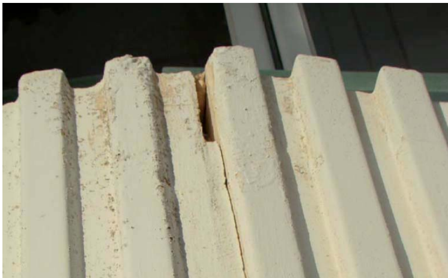
Figura 6 Fisuras verticales en las juntas de mortero entre las placas.
