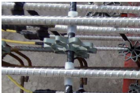
Figura 7 Aislamiento de las barras de acero inoxidable.
