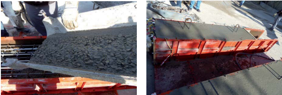
Figura 9 Hormigonado y fraguado de los Bartolos.
